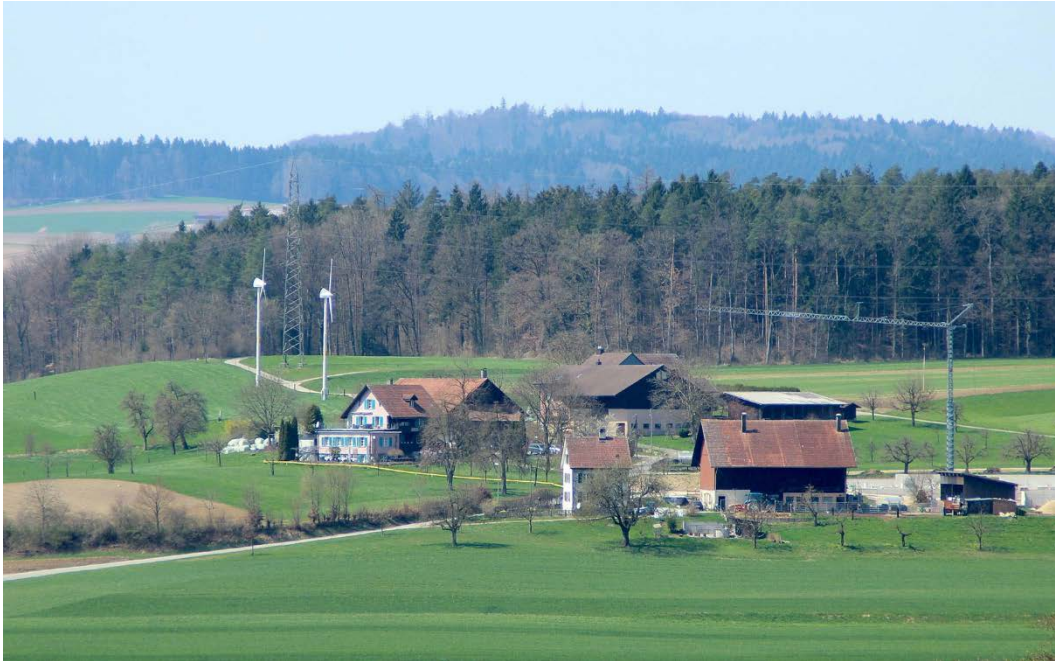
Abbildung 2 Kleinwindenergieanlagen als Teil eines Gebäudeensembles in der Landwirtschaftszone (Taggenberg, Bildquelle: Adrian Michael - Eigenes Werk, CC BY-SA 3.0, https://commons.wikimedia.org/w/index.php?curid=25681073 )
